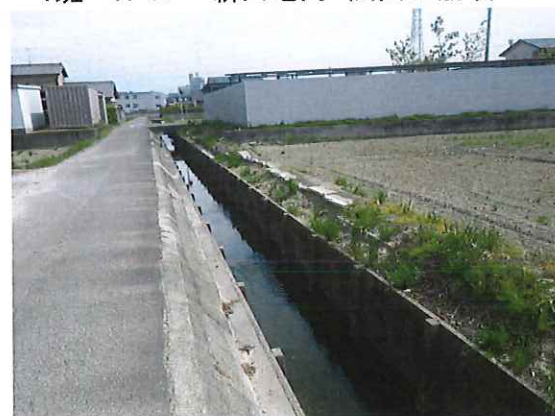
2班 k-12 唐生地内 法面コン板復旧
