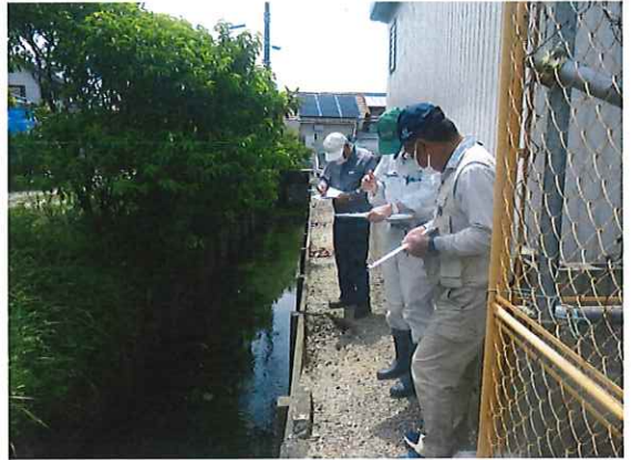
2班 k-14 青木地内 排水路沿土砂流出
