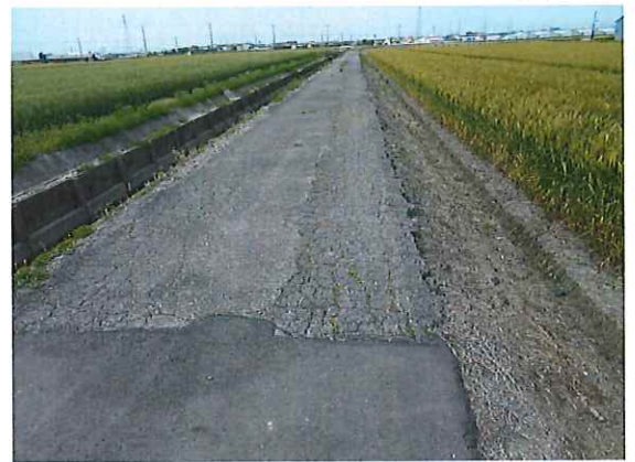
1班 R-1 六畝地内 舗裝修繕
