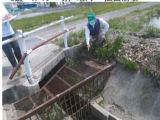
3班 K-17 半夏地内 防塵柵修繕
