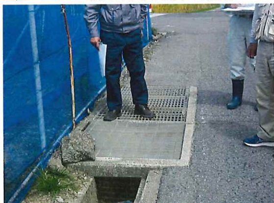
2班 P-3 唐生地内 排泥柵上部蓋修繕
