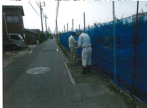
2班 P-3 唐生地内 排泥柵上部蓋修繕
