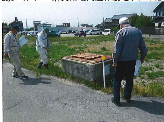
2班 P-1 唐生地内分水柵上部蓋修繕
