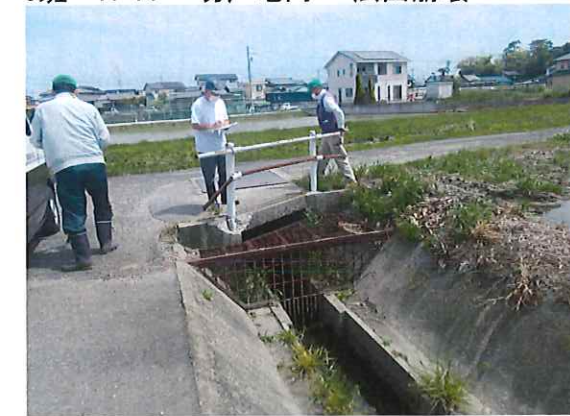
3班 K-17 半夏地内 防塵柵修繕
