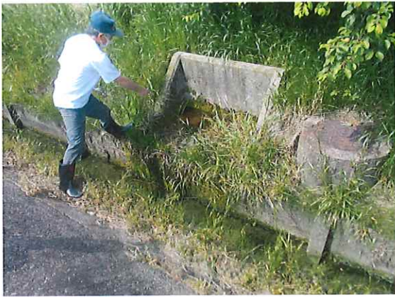
3班 P-4 屋下地内 排泥柵上蓋修繕
